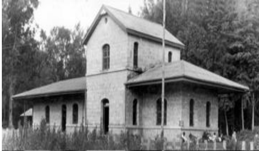
FIGURA 08. Fotografía antigua de la Estación Uruapan, vista de la fachada posterior. Fotografía tomada del catálogo de Centro de Documentación e Investigación ferroviaria (CEDIF), consultado el 19 de junio del 2015.
