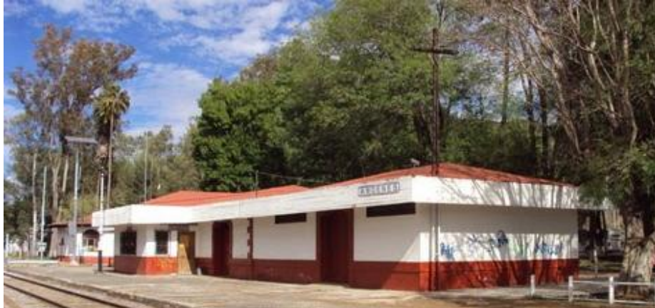
FIGURA 04. Fotografía actual, en donde se observa la cubierta modificada de la antigua estación Pátzcuaro. Imágenes tomadas del Catálogo Nacional de Estaciones ferroviarias de CONACULTA.
